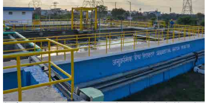
बीएचईएल ने हरिद्वार में अपने कारखाना परिसर और उपनगरी के लिए सिक्वेंशियल बैच रिक्टर प्रौद्योगिकी पर आधारित 7 एमएलडी क्षमता वाला सीवेज ट्रीटमेंट प्लांट (एसटीपी) स्थापित किया
