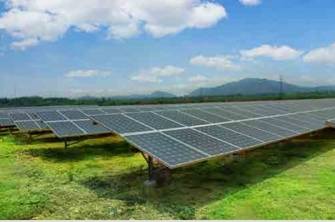
बीएपी, रानीपेट में कैप्टिव पावर उत्पादन हेतु घरेलू 5 मेगावाट सोलर पीवी स्थापना
