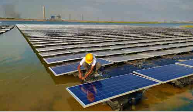
बीएचईएल द्वारा सागरदिघी थर्मल पावर प्लांट में कमीशन किया गया 5 मेगावाट एसी ग्रिड कनेक्टेड फ्लोटिंग सोलर पीवी प्रोजेक्ट
